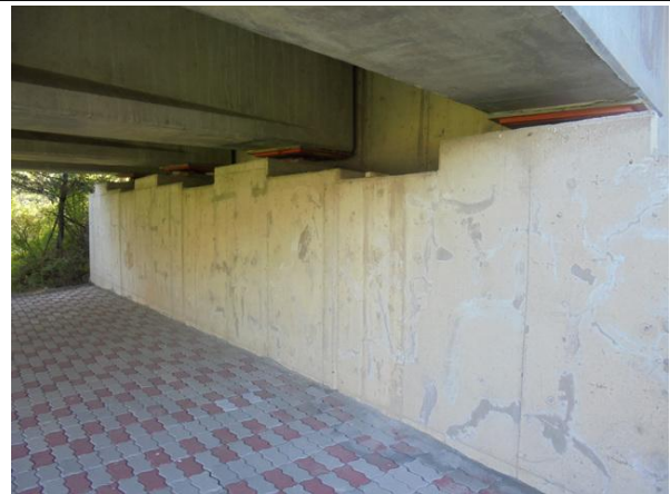
교대 A2 기초 전경
