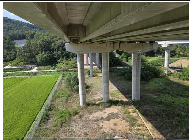
교각 P3 기초 전경
