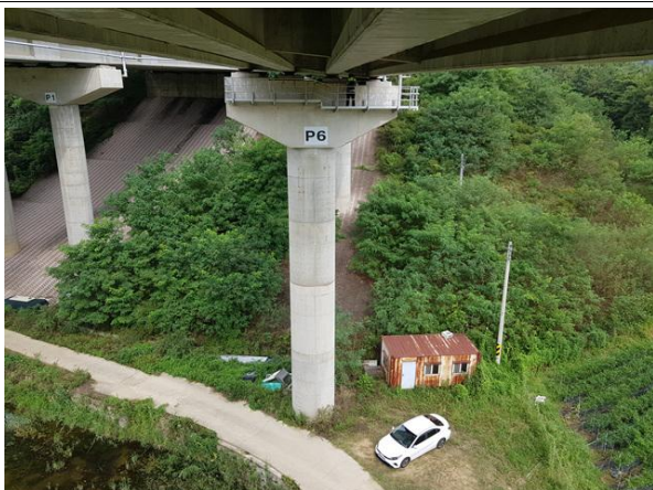
교각 P6 기초 전경
