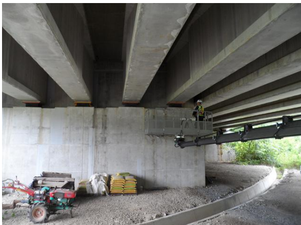
고소점검차를 이용한 근접조사
