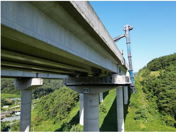
고소점검차를 이용한 근접조사
