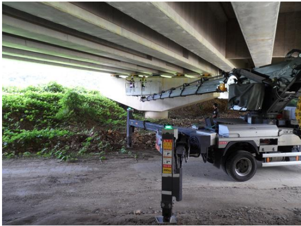
고소점검차를 이용한 근접조사
