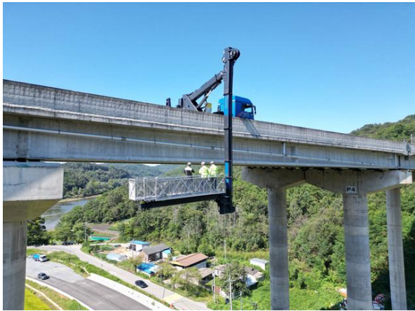
굴절점검차를 이용한 근접조사
