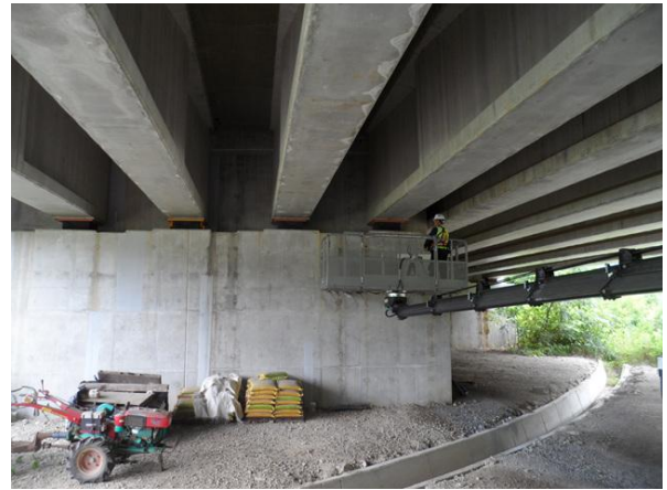
교대 A2 기초 전경
