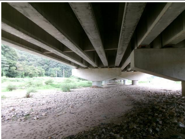
교각 P4 기초 전경
