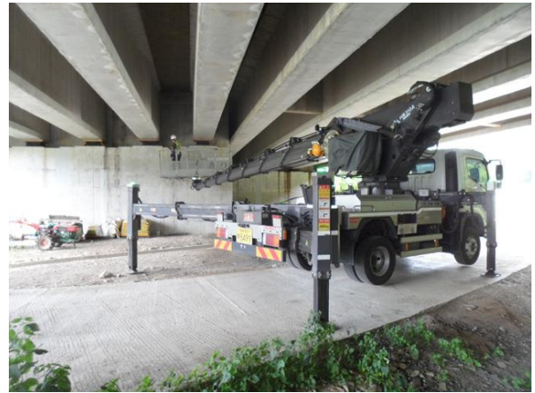
고소점검차를 이용한 근접조사
