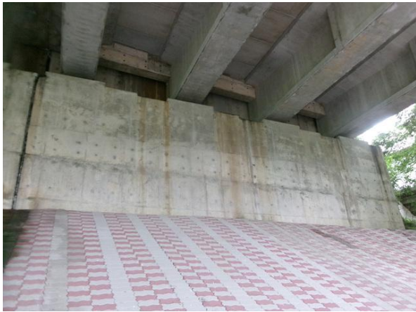
교대 A1 기초 전경
