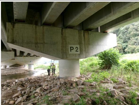
교각 P2 기초 전경
