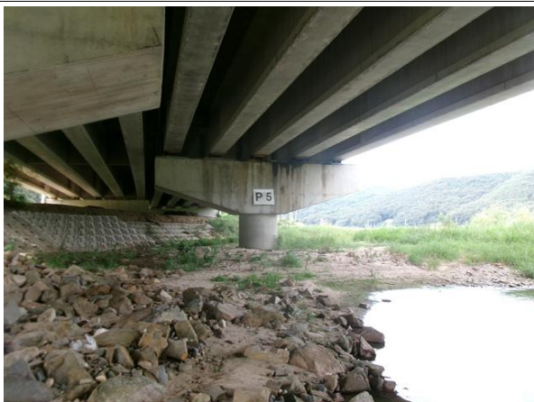
교각 P2 기초 전경
