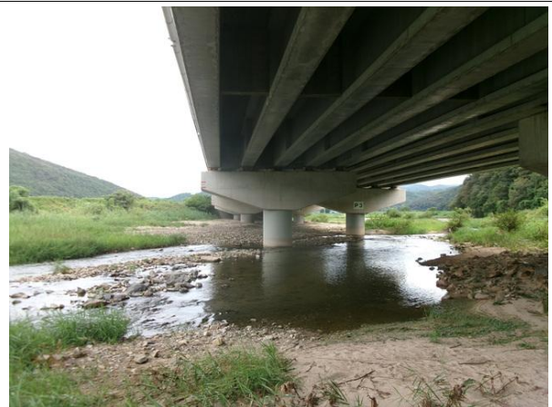
교각 P3 기초 전경
