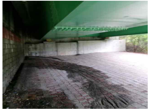
교대 A2 기초 전경
