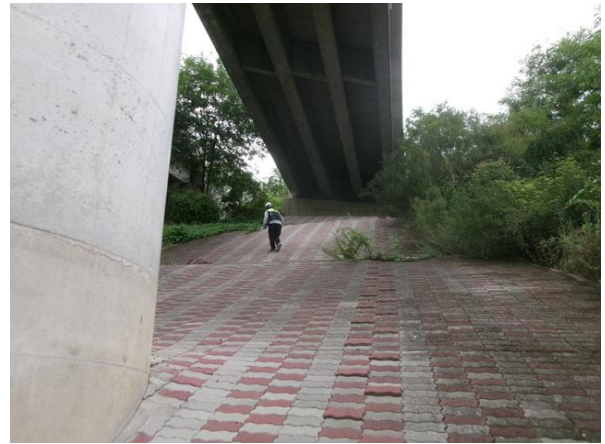
교대 A2 기초 전경
