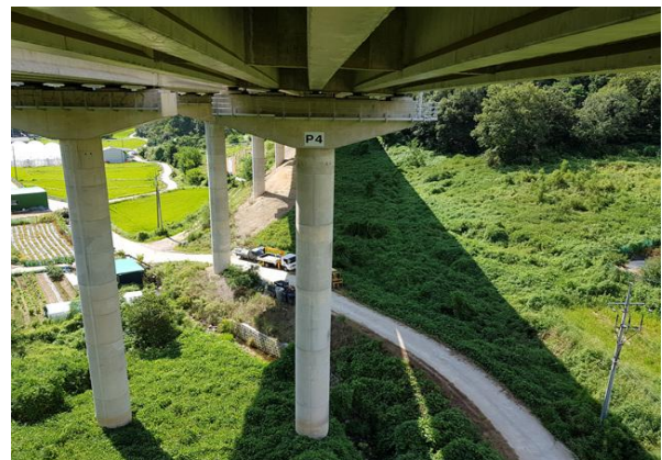
교각 P4 기초 전경
