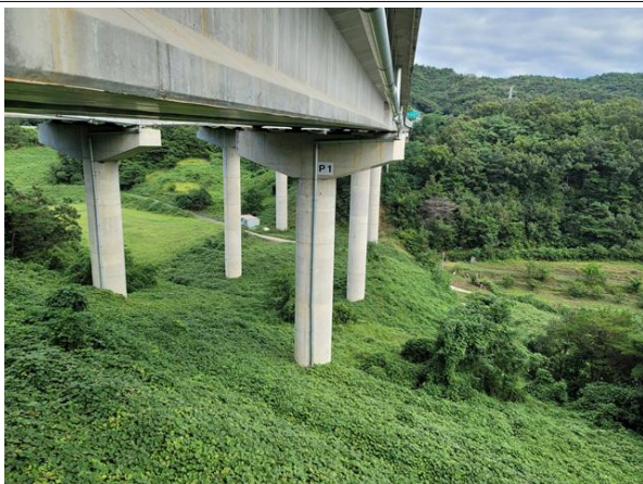
교각 P1~2 기초 전경
