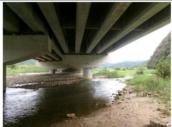
교각 P3 기초 전경
