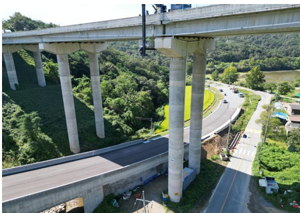
교각 P4~5 기초 전경
