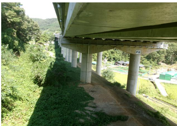
교각 P8 기초 전경
