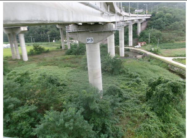
교각 P3~5 기초 전경
