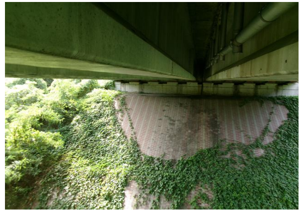
교대 A2 기초 전경
