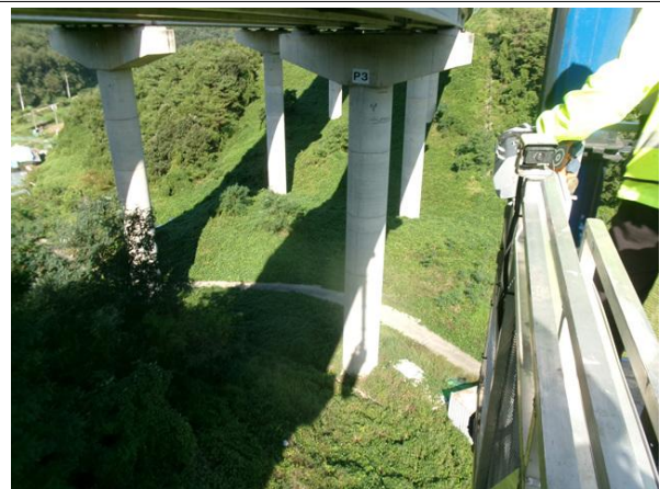
교각 P3기초 전경
