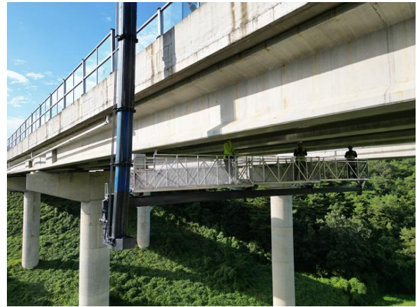
굴절점검차를 이용한 근접조사
