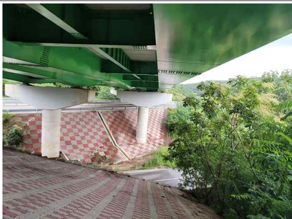
교각 P1 기초 전경
