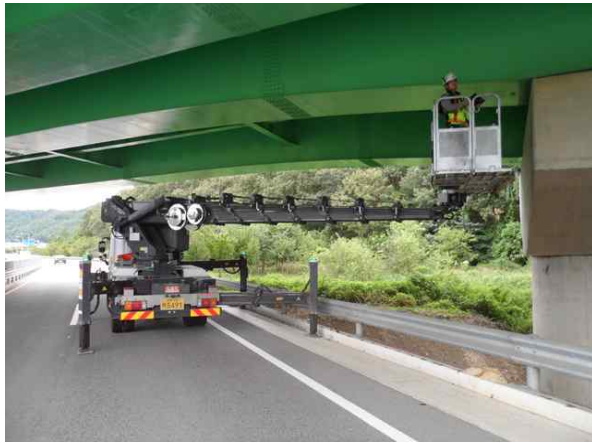
고소작업차를 이용한 부재치수 현장측정
