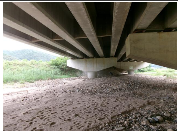
교각 P5 기초 전경
