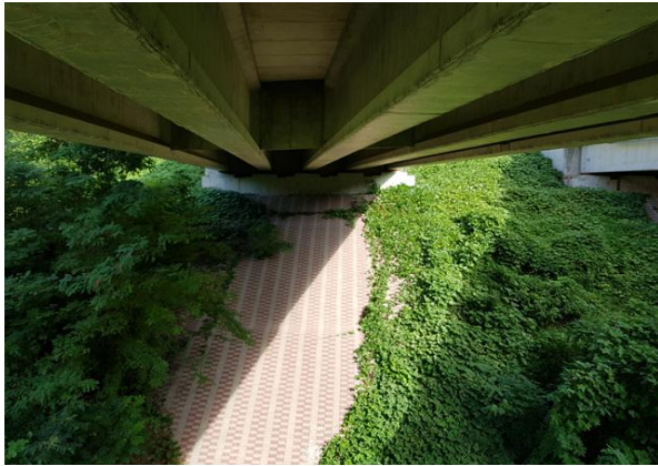
교대 A1 기초 전경
