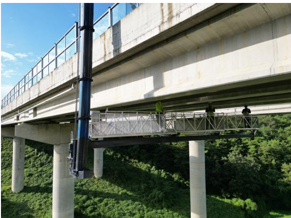
고소점검차를 이용한 근접조사
