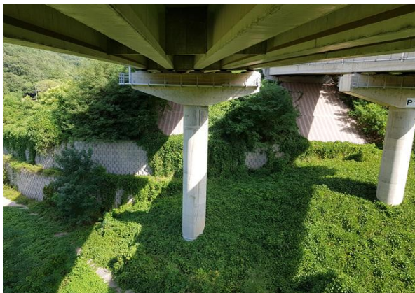
교각 P1 기초 전경
