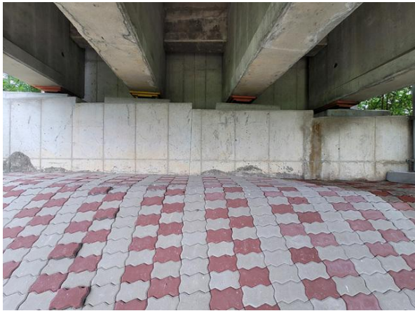
교대 A1 기초 전경
