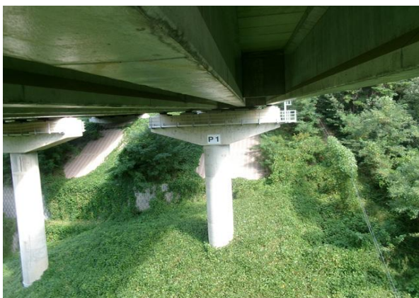
교각 P1 기초 전경
