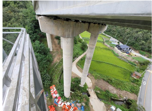
교각 P3 기초 전경
