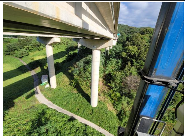
교각 P3기초 전경
