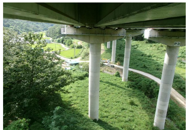
교각 P4 기초 전경
