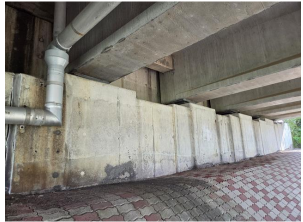
교대 A2 기초 전경
