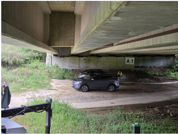
교대 A1 기초 전경
