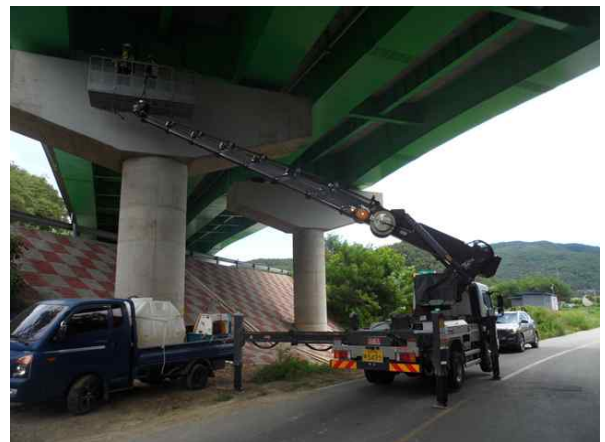
고소점검차를 이용한 근접조사
