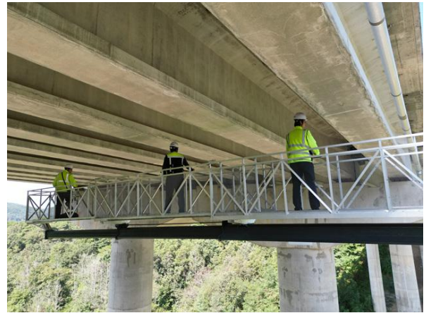
굴절점검차를 이용한 근접조사
