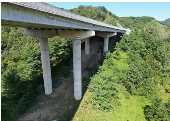
교각 P1~2 기초 전경
