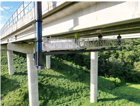
굴절점검차를 이용한 근접조사
