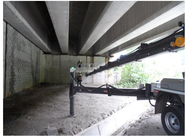
교대 A2 기초 전경
