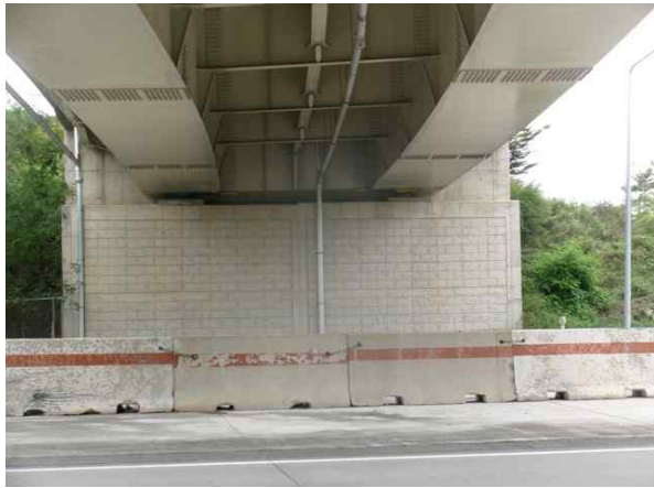
교대 A1 기초 전경
