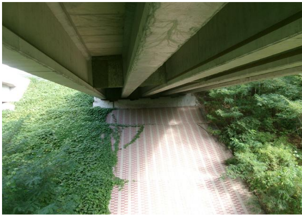
교대 A1 기초 전경
