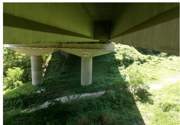
교각 P10 기초 전경
