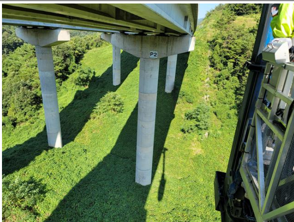
교각 P1~2 기초 전경
