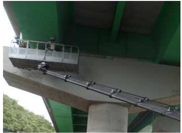
고소작업차를 이용한 부재치수 현장측정
