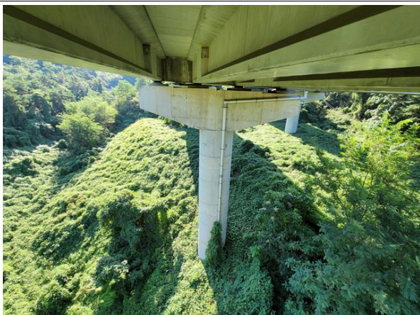
교각 P4 기초 전경
