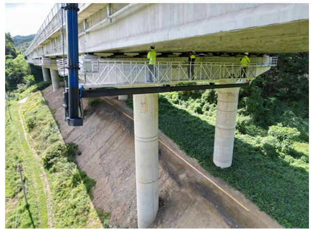
굴절점검차를 이용한 근접조사
