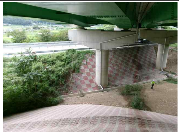
교각 P2 기초 전경
