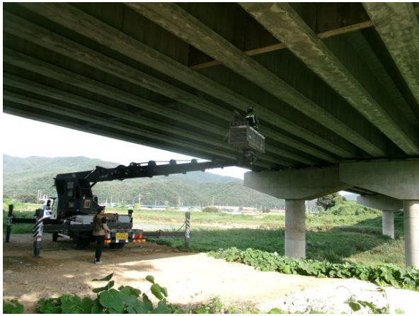
굴절점검차를 이용한 근접조사
