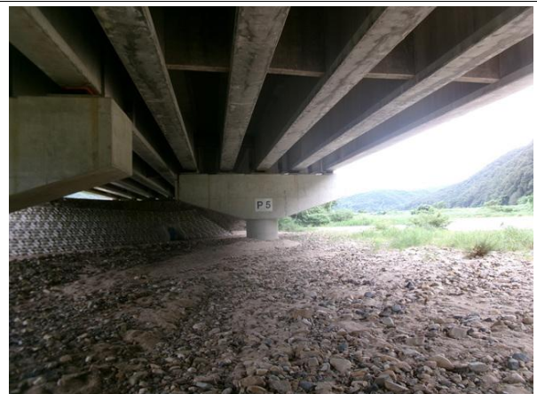
교각 P5 기초 전경
