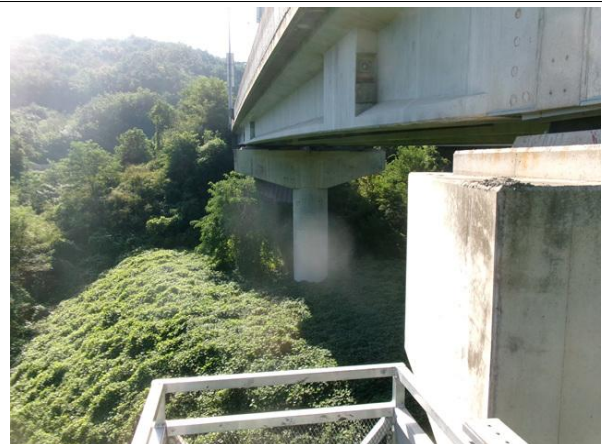
교각 P5 기초 전경
