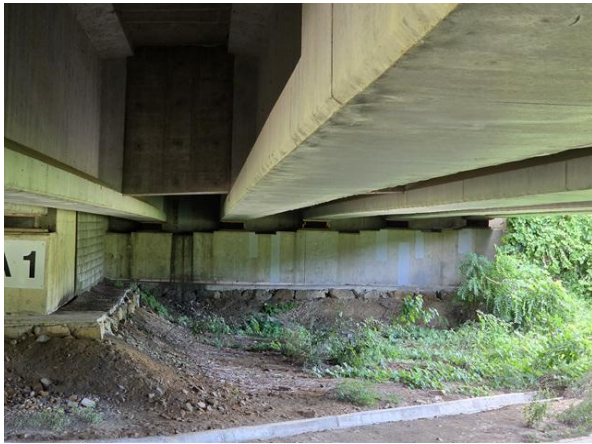
교대 A1 기초 전경
