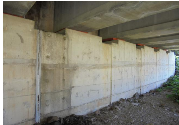
교대 A2 기초 전경
