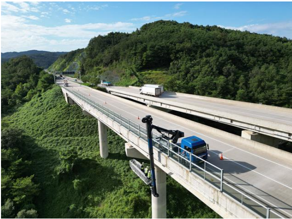
굴절점검차를 이용한 근접조사
