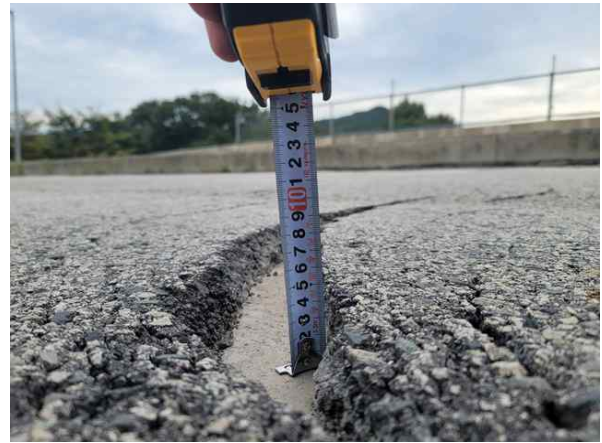
줄자를 이용한 부재치수 현장측정
