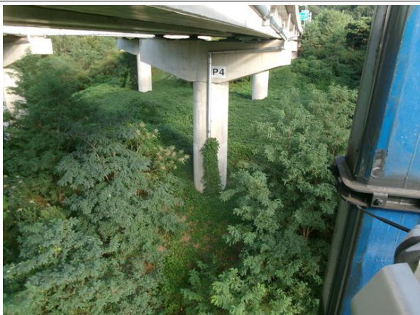
교각 P4 기초 전경
