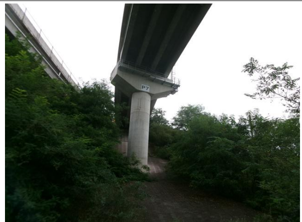
교각 P7 기초 전경
