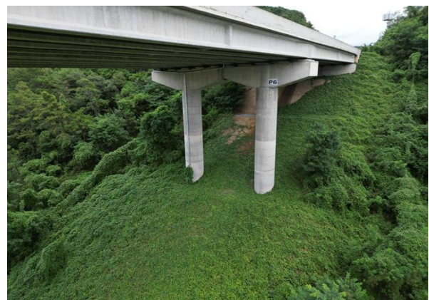
교각 P6 기초 전경
