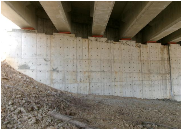
교대 A1 기초 전경
