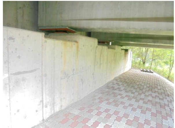
교대 A2 기초 전경
