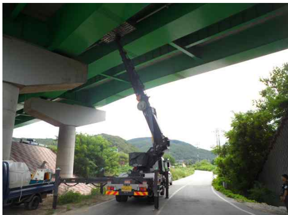
고소점검차를 이용한 근접조사
