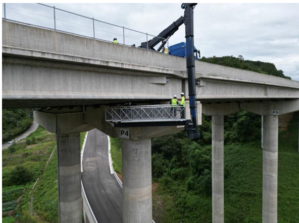
굴절점검차를 이용한 근접조사
