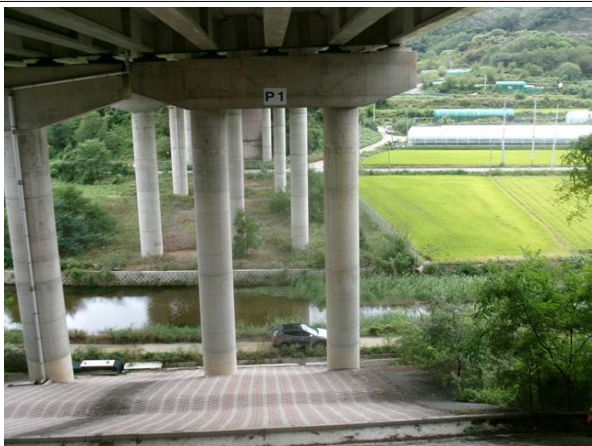
교각 P1 기초 전경
