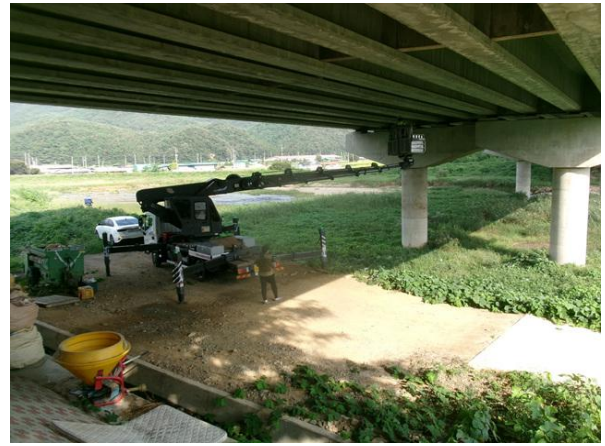
굴절점검차를 이용한 근접조사
