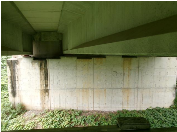
교대 A1 기초 전경
