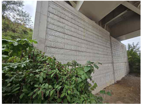
교대 A2 기초 전경
