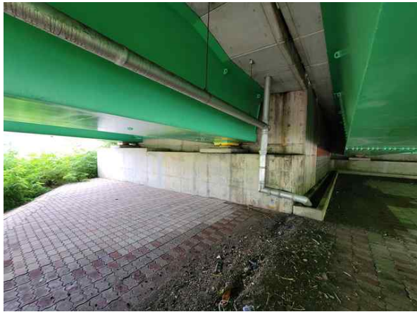
교대 A1 기초 전경
