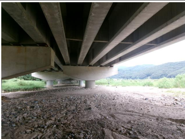
교각 P4 기초 전경
