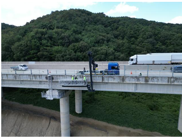
굴절점검차를 이용한 근접조사
