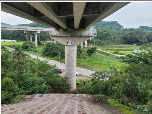
교각 P1 기초 전경
