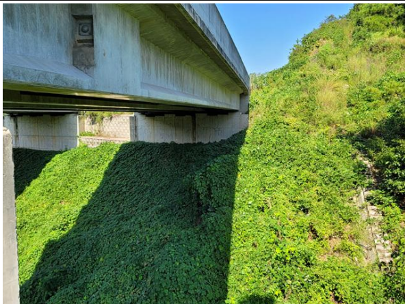
교대 A1 기초 전경
