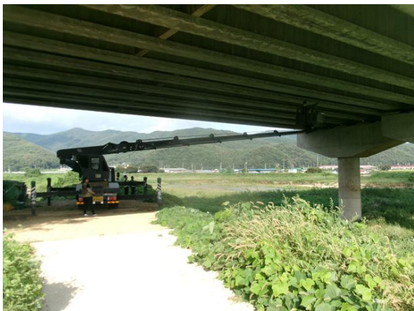
굴절점검차를 이용한 근접조사
