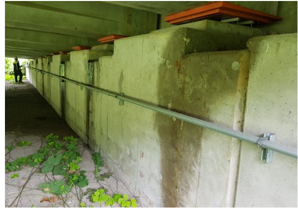
교대 A2 기초 전경
